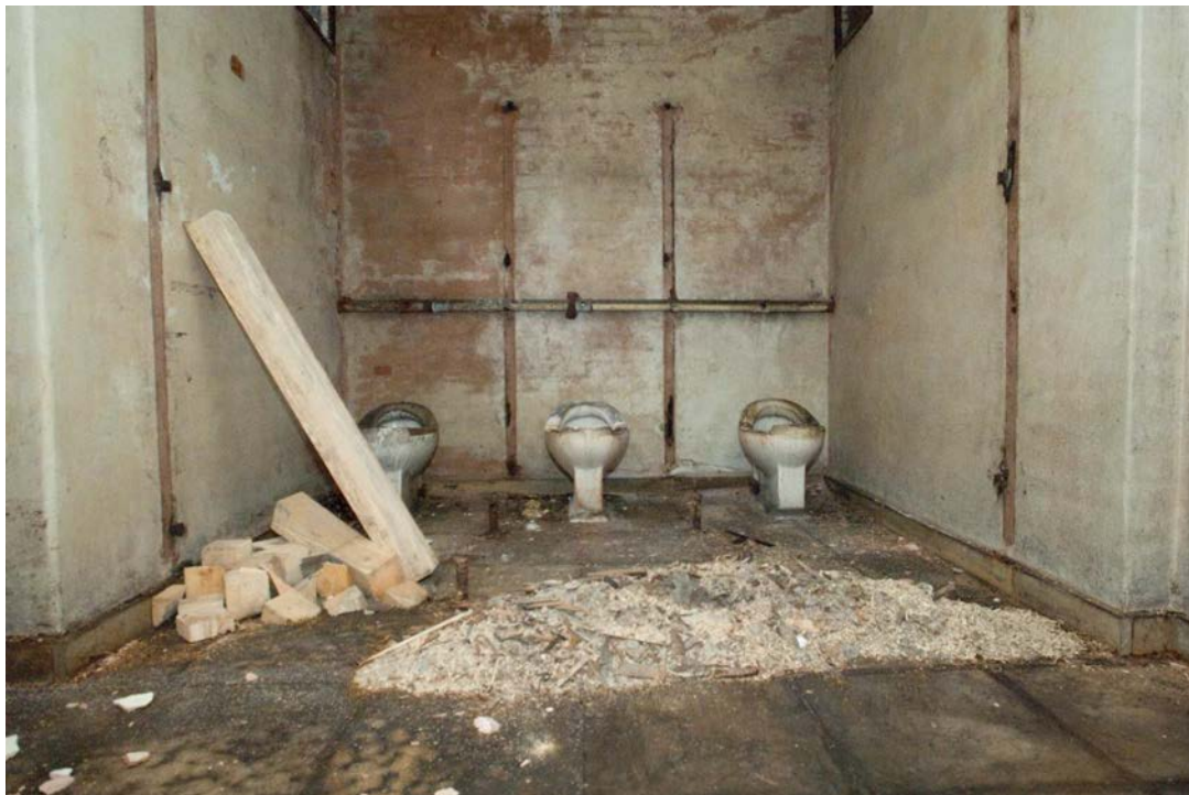
Toilettenanlagen in der Zeppelintribüne. Foto: Stadt Nürnberg / Presseamt, Dierenbach
